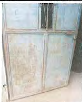
Foto 3: Sustitucion de puerta de metal por metal en cocina.
