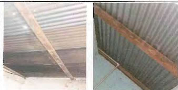
Foto 2: sustitución de estructura de madera por metal en cocina y baños.
