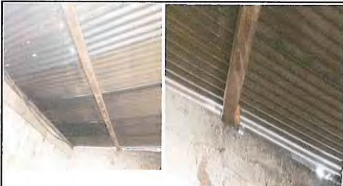
Foto1: Sustitucion de lamina canalada por lamina troquelada en cocina y baños.
