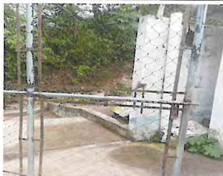
Foto 6: Mantenimiento de Porton de metal
