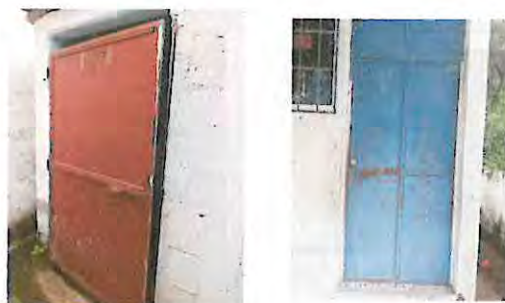
Foto 4: Mantenimiento a puerta de metal (, pintura) en salones
