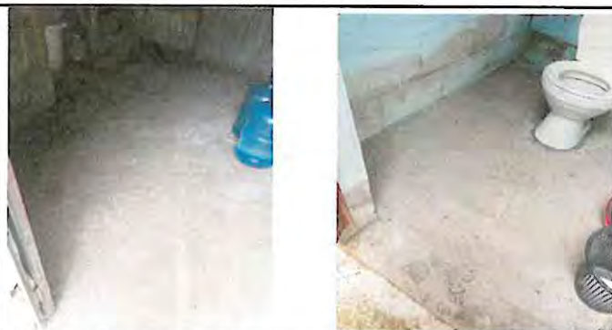
Foto 5: Suatitucion de piso de concreto por piso ceramico antideslizante en cocina y baños.
